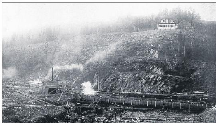
Der Bau des Mauerfundaments: Dieses Bild entstand im Jahr 1912. Die Sperre wurde zwischen Eisenberg und Buddenberg (im Hintergrund) errichtet.
